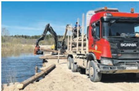
В дорожную службу Устьянского леспромпхоза поступило два новых вибропогрузателя DaeDong. Оборудование позволит ускорить процесс установки свай, шпунтов, балок и труб при строительстве деревянных мостов. Специалисты подразделения уже успели применить вибропогрузатели при строительстве дорожной переправы в селе Студенец.
